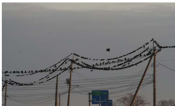
195. 西区曾和IC付近 12月19日7:25 危険を感じると近くの電線に避難する
