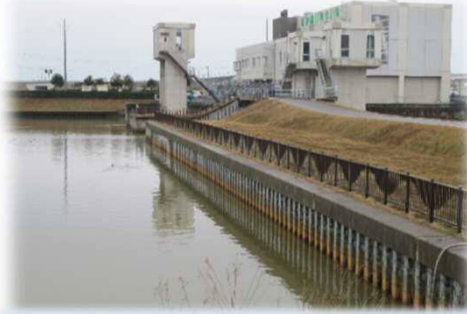
新井郷川排水機場
