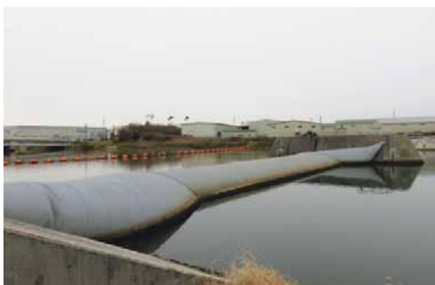
福島潟放水路の豊栄潮止堰
