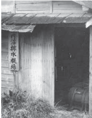
図-23 明治25年、日本最初の旧巻町内沼排水機場 (出典：西蒲原郡土地改良区 写真集)
