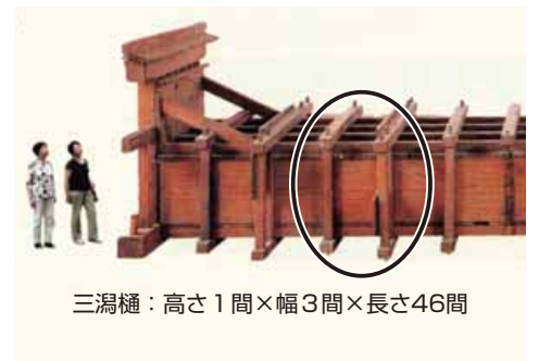
当時の底樋の大きさと発見された柱の位置
