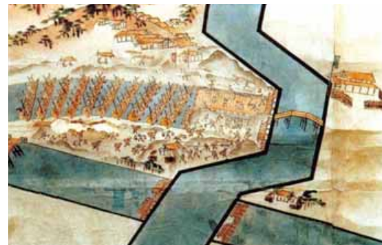
踏み車53台を使って排水しながらの底樋工事(出典:新潟市史資料編4近世Ⅲ)
