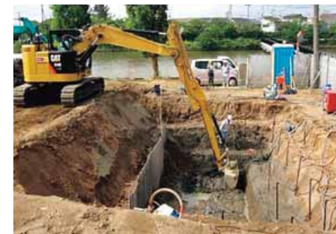
地下4メートルまで掘り下げた新川沿いの掘削現場
