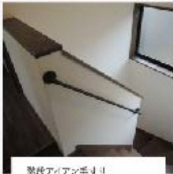
階段アイアン手すり
