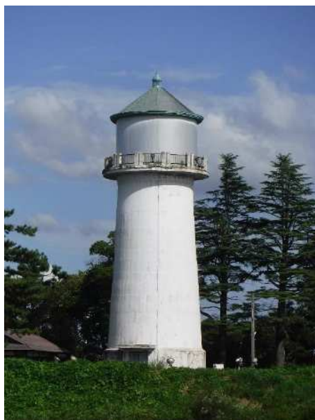
旧白根配水塔
