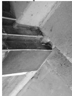
・額縁の下部にも破損が見られる
