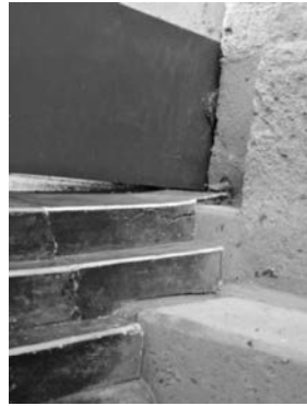
・額縁の下部に破損が見られる
