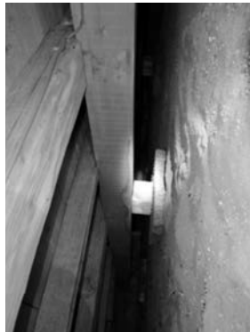
・床組はほぼ健全な状態
