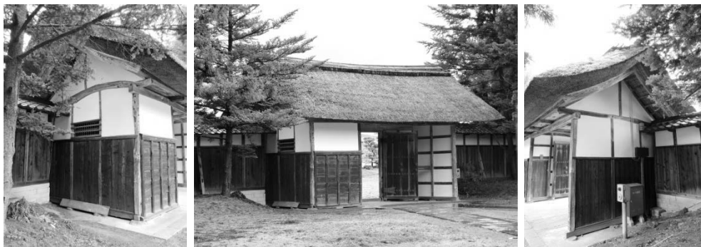
・軸組、小屋組、基礎とも健全な状態
