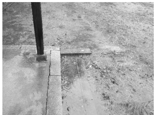
機能が低下している雨落
