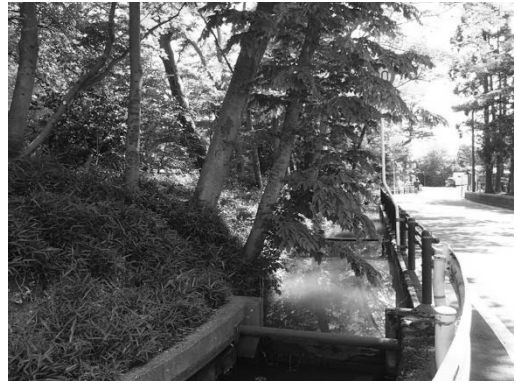
土塁上の樹木と堀にかかるパイプ
