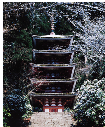
6. 雪の室生寺五重塔全景 1978（昭和53）年
