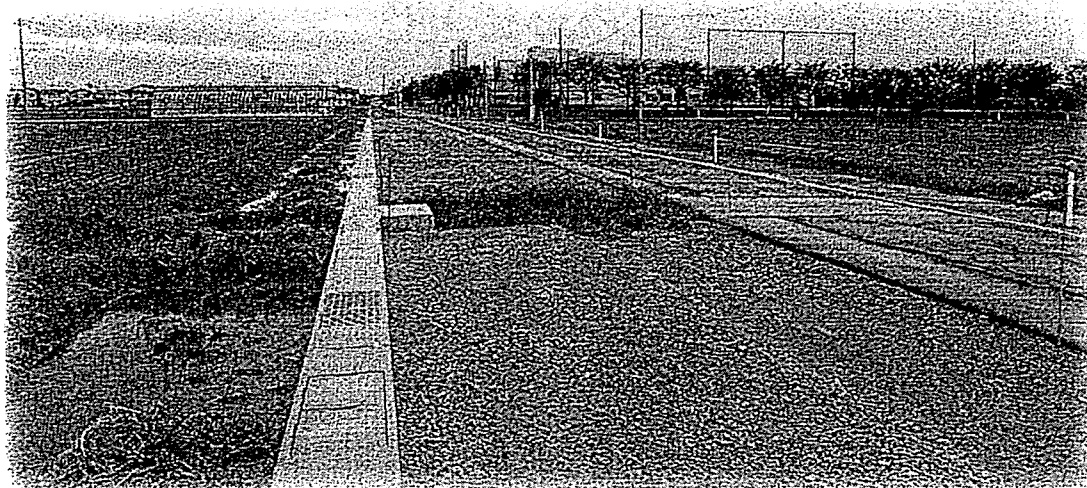
舗装が待たれる道路
