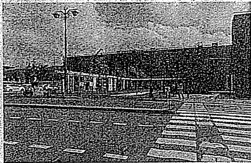
工事が進む新潟駅 万代口
