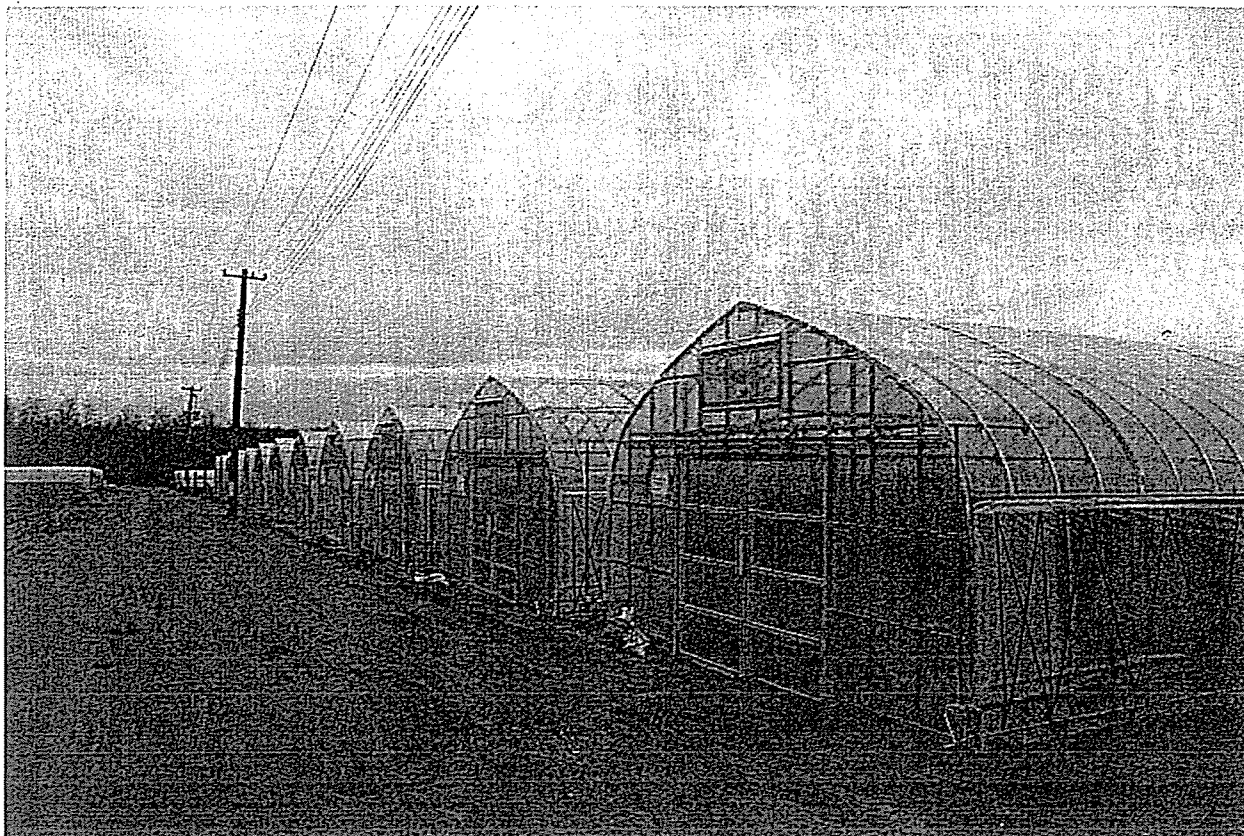
新潟市北区では昨年、市の補助金を活用して20棟のハウスが新たに建てられた
