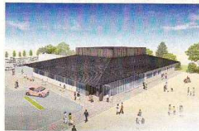
三角防災拠点センター
