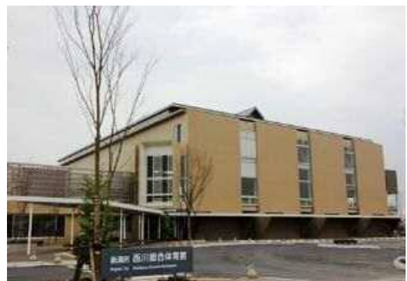
西川総合体育館
