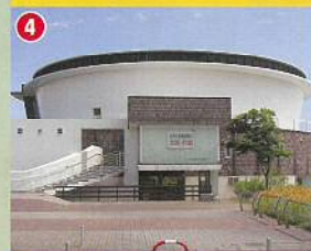
④遊水館(プール)
