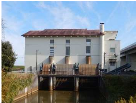
洪水被害から農地や市街地を守る 本所排水機場
