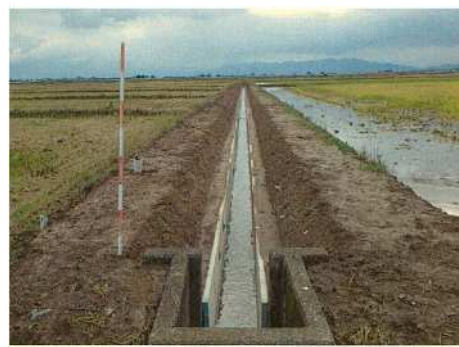
土水路から排水フリュームへの更新
