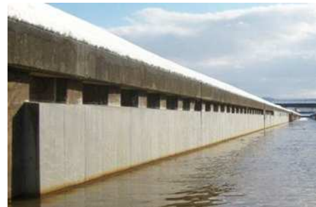
鋼矢板水路の腐食対策
