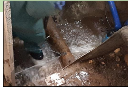
写真1 漏水したCIPの修理現場
