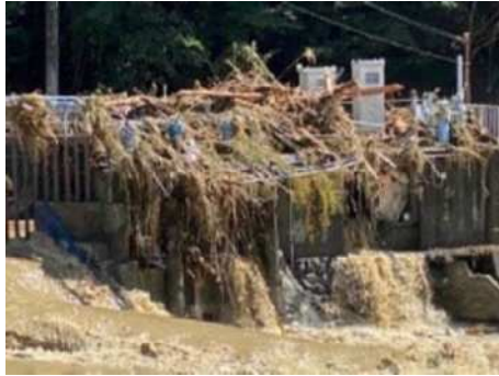
静岡市ホームページから 土砂・流木が堆積する興津川承元寺取水口
