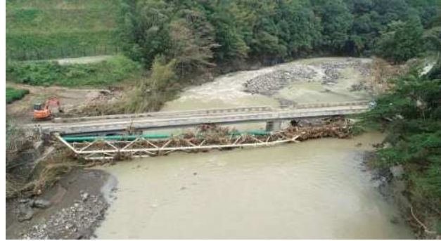
静岡市ホームページから 落橋した宮嶋橋水管橋（緑色が配水管）
