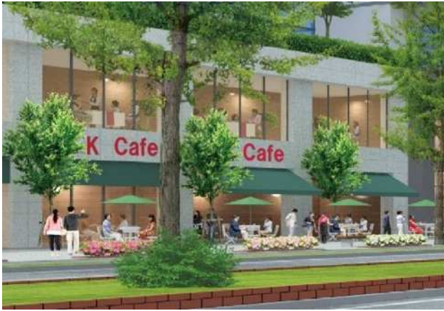
透視可能なデザインにより、建物内部の賑わいが屋外にいても感じられ、歩いて楽しい空間
