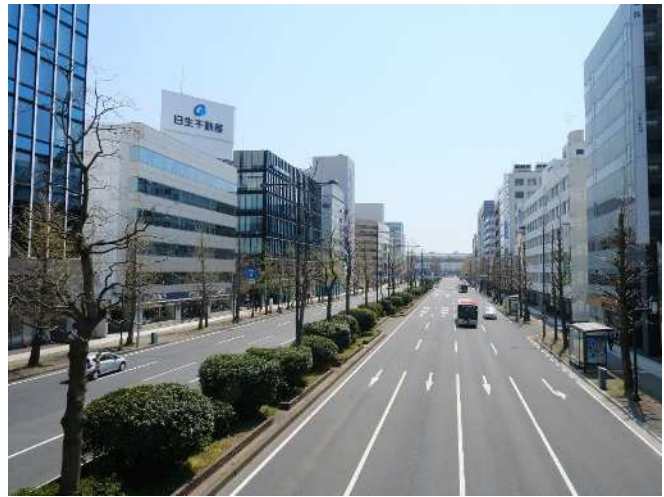
東大通沿いに壁面がそろった現状の景観
