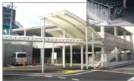
改修された小針駅駐輪場
