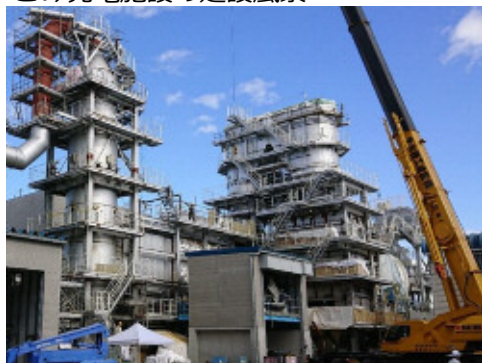
■ ごみ発電施設の建設風景
