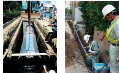
耐震管への更新工事
