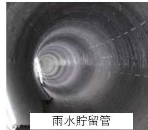
浸水対策施設の整備
