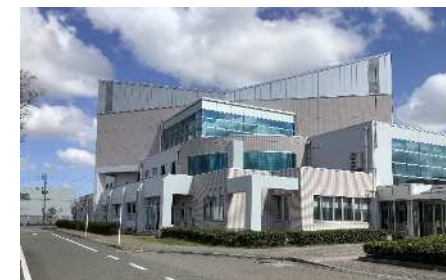
公共施設の長寿命化対策実施事例 (屋上、外壁を改修した横越総合体育館)
