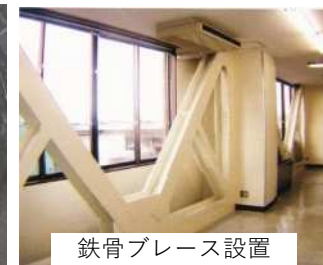
下水処理場の耐震化
