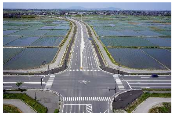
新潟中央環状道路 横越バイパス
