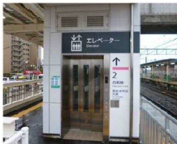
エレベーター設置(JR東新潟駅)
