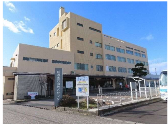
写真 6-35 石山地区センター
