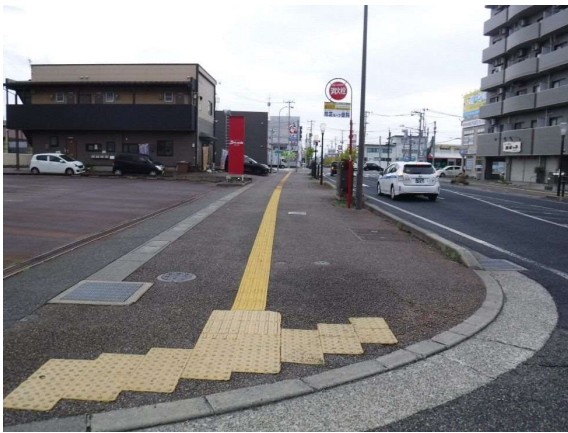
写真 2-3 視覚障害者用誘導ブロック
