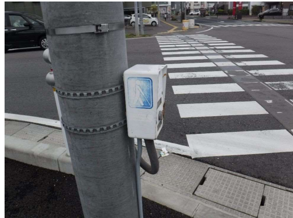
写真 2-8 青延長用押ボタン付き信号機
