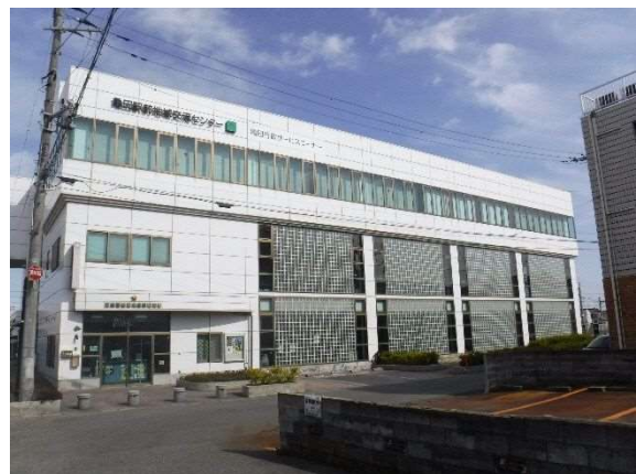
写真 6-27 亀田駅前地域交流センター
