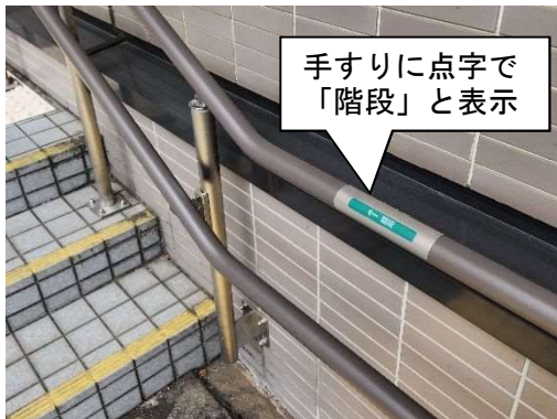
写真 6-5 手すりの案内表示（点字）
