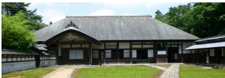
重要文化財旧笹川家住宅
