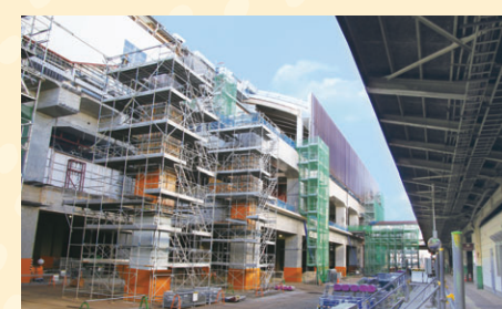
旧1番線ホームから見た新駅舎の正面(令和2年11月撮影)
