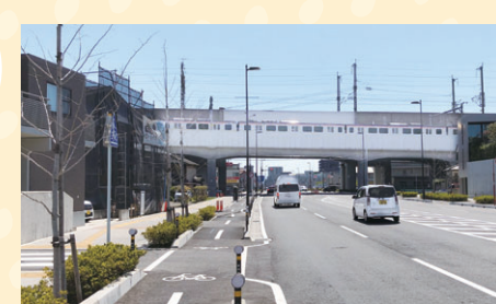
新潟鳥屋野線(中央区水島町付近)
