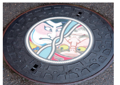
▲風合戦専用マンホール。写真は白根側のもの。ふたの下には支柱を立てる土台の穴が隠れている
