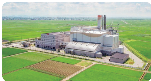
▲ごみ焼却熱で発電を行っている新田清掃センター
