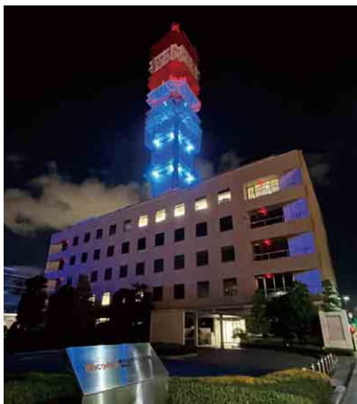
ドコモ新潟ビル 屋上鉄塔(写真提供:(株)ドコモCS)
