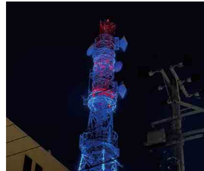
電力ビル新潟 無線鉄塔(写真提供:東北電力(株))
