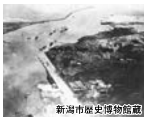
築港の埋め立て工事
