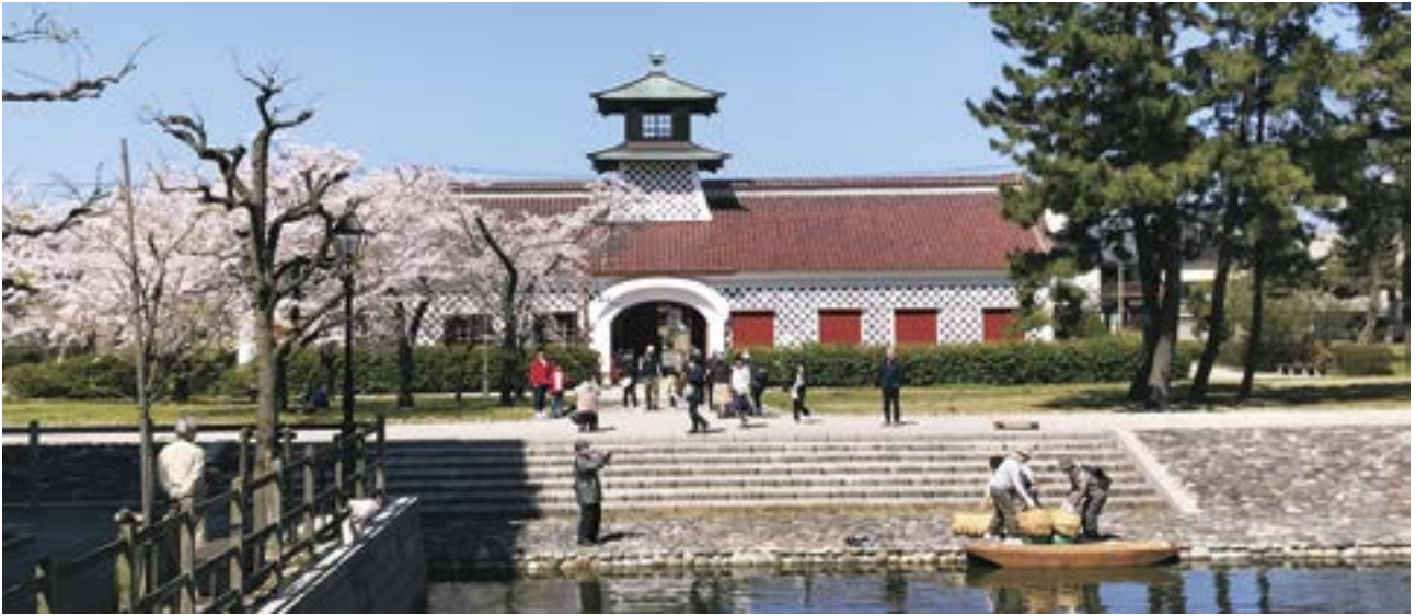
旧新潟税関庁舎等整備活用事業 開港五港で唯一現存する税関遺構を、開港150周年を契機として耐震対策や内外装の保存修理工事を実施。
