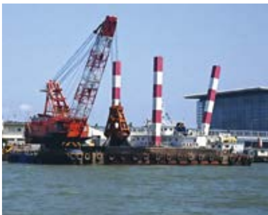
新潟港西港地区整備事業 信濃川河口に位置する西港地区の港内埋没を防ぐため、浚渫及び第二西防波堤整備を実施。明治 42 年からの継続事業。（右写真：新潟市歴史博物館蔵）
