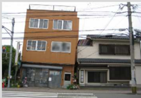
①住宅の沈下・傾斜
