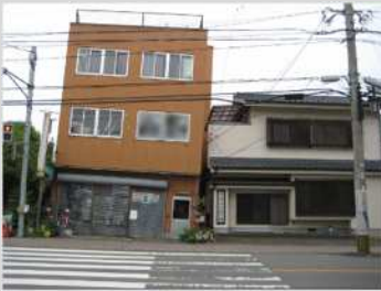
住宅の沈下・傾斜
