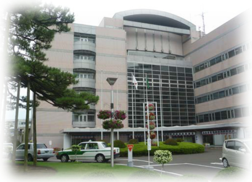
市役所 本庁舎本館
